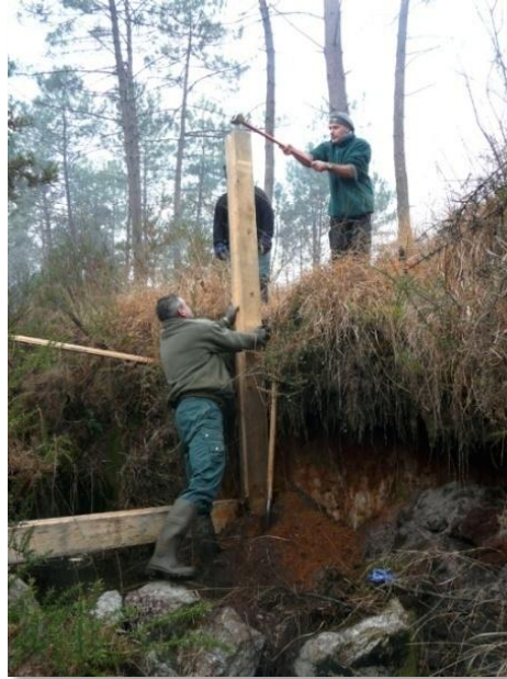
Pose et entretien de de barrages seuils, bouchage des drains, et suivi des effets de la gestion
