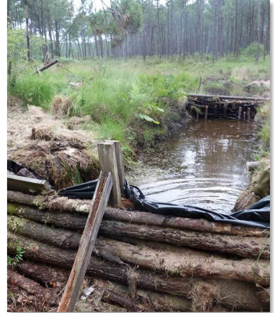
Pose et entretien de de barrages seuils, bouchage des drains, et suivi des effets de la gestion
